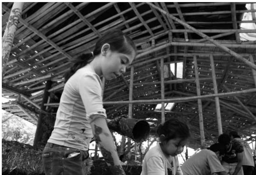
Figura 3 • Construyendo con Cob y pacas de paja l
